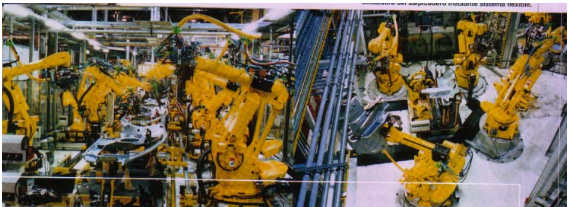
(Procesos de soldadura)
